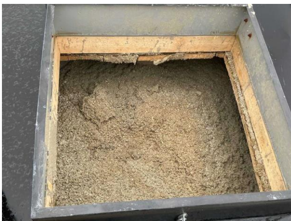
Bild 8: - Utvändigt, Vind, Vinden är för trång att besikta då den är fylld med Ecofiber isolering Vind ovan tillbyggnad sak...
