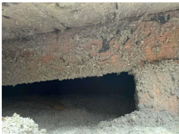
Bild 7: - Utvändigt, Vind, Vinden är för trång att besikta då den är fylld med Ecofiber isolering Vind ovan tillbyggnad sak...
